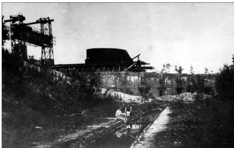
Esimese maailmasõja aegse 14-tollise patarei nr. 10-a parempoolse soomustorni mahamonteerimine Naissaare merekindluses 1923. aastal. Foto autor teadmata. EFA.477.P. 0-166785
