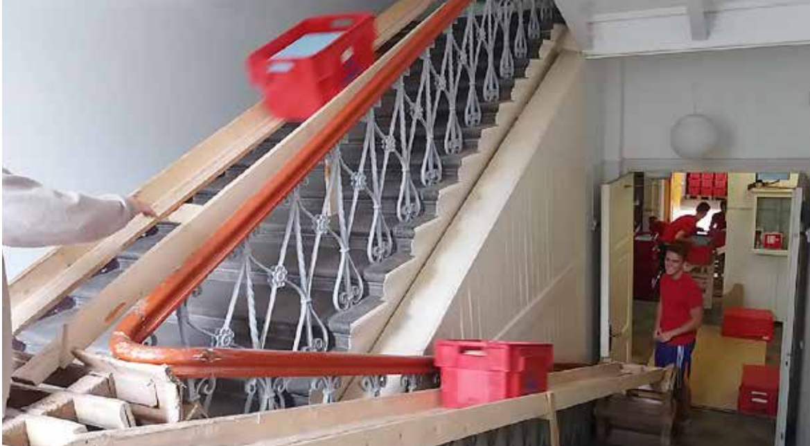
Suurema osa arhivaalide transportimiseks kasutatud korrustevaheline laudtee
