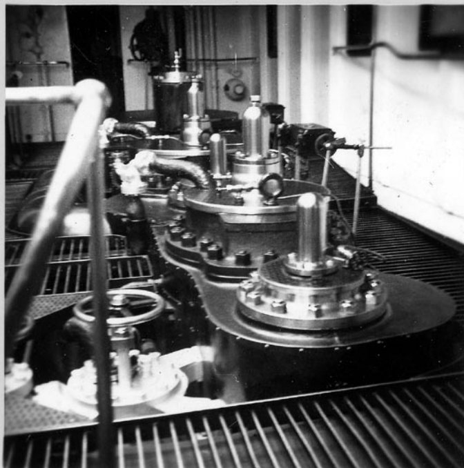
Jäämuraja masinaruum. Laeval oli kolm peamasinat – üks vööris ja kaks ahtris. Katlaid oli kokku kuus. Laeva algne kiirus oli 15 sõlme ning see suutis takistusteta murda meetripaksust jääd. EMM F 401:4
