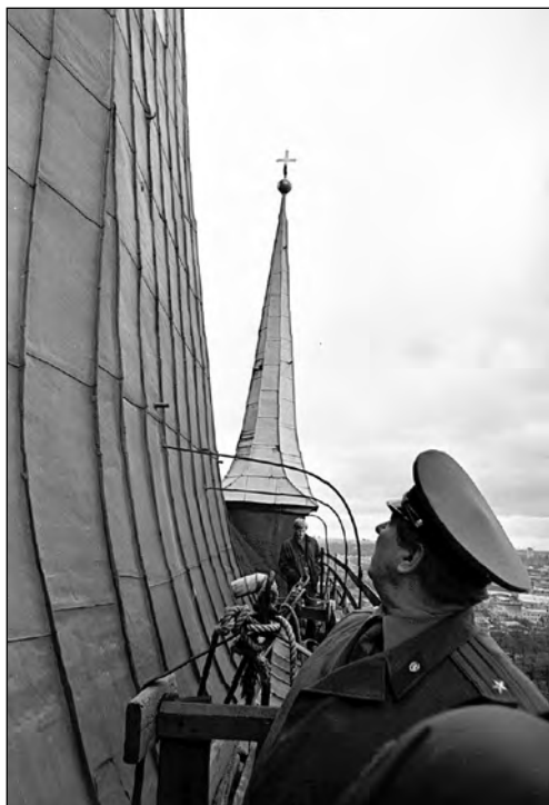
Sideliinid Oleviste kiriku tornil, üks neist side ja teine toiteallika tarvis. 1990. a. Foto: Albert Truuväart, EFA 0-257060
