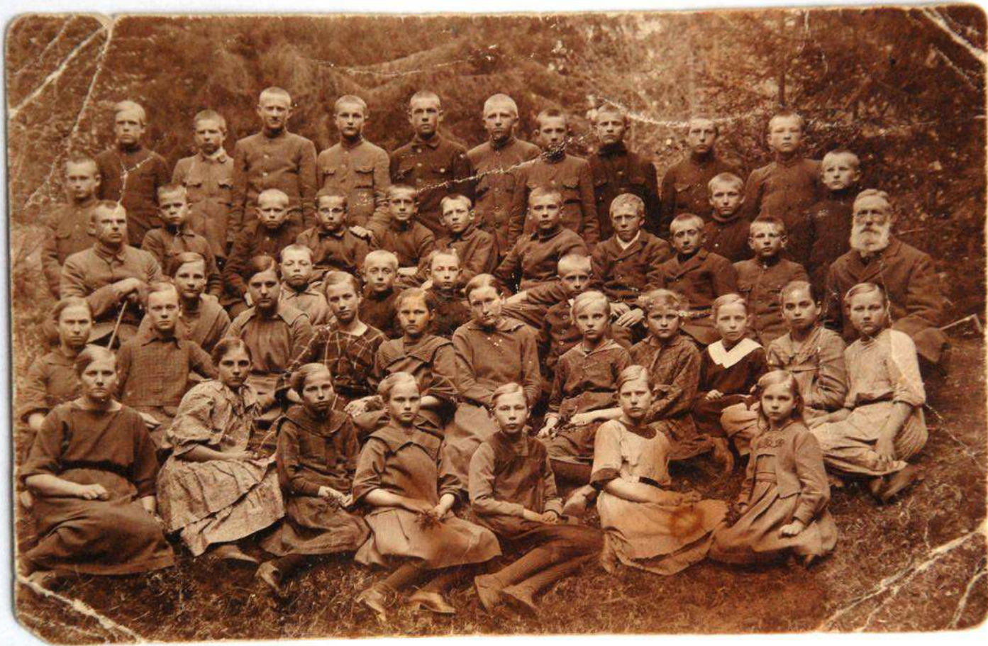
Plekid ja mehaanilised kahjustused (rebendid, voldid, muljumisjäljed) hõbeželatiinfoto pinnal. Kadi Sikka erakogu
